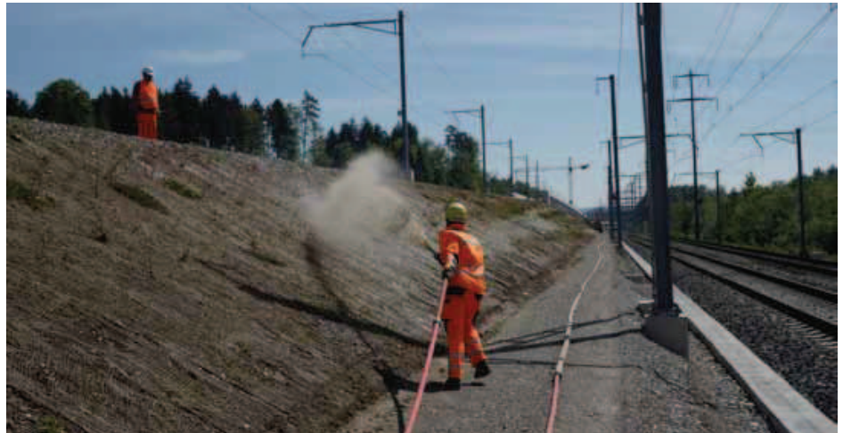
Mit Hydrosaat (Anspritzverfahren) kann Heudrusch-Saatgut auch auf steilen und grossen Flächen ausgebracht werden. Alle Fotos: A. Bosshard
