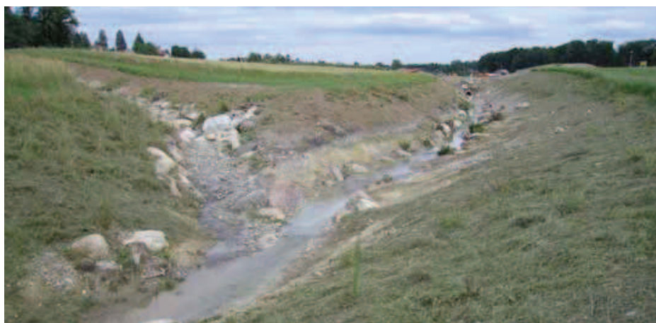
Direktbegrünung mit der Heugrassaas-Methode entlang eines renaturierten Bachlaufes und auf einer Wegböschung.
